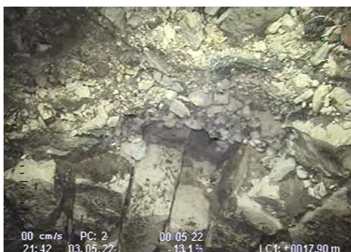
Slika 3. Snimak urušenog svoda starog dijela kanala Pragrande
