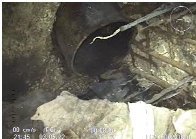
Slika 4. Snimak prodora slivnika u novi dio AB kanala Pragrande
