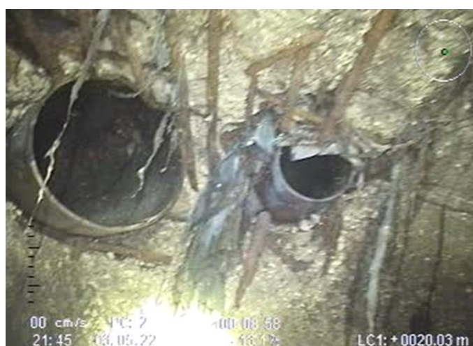
Slika 5. Snimak prodora slivnika u novi dio AB kanala Pragrande
