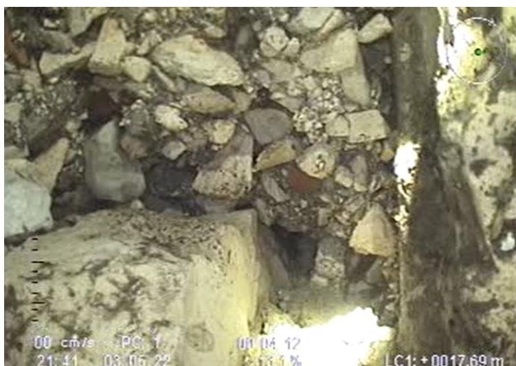
Slika 2. Snimak urušenog svoda starog dijela kanala Pragrande
